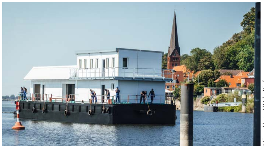
Die neue Bunkerstation ist auch für alternative Kraftstoffe ausgelegt
