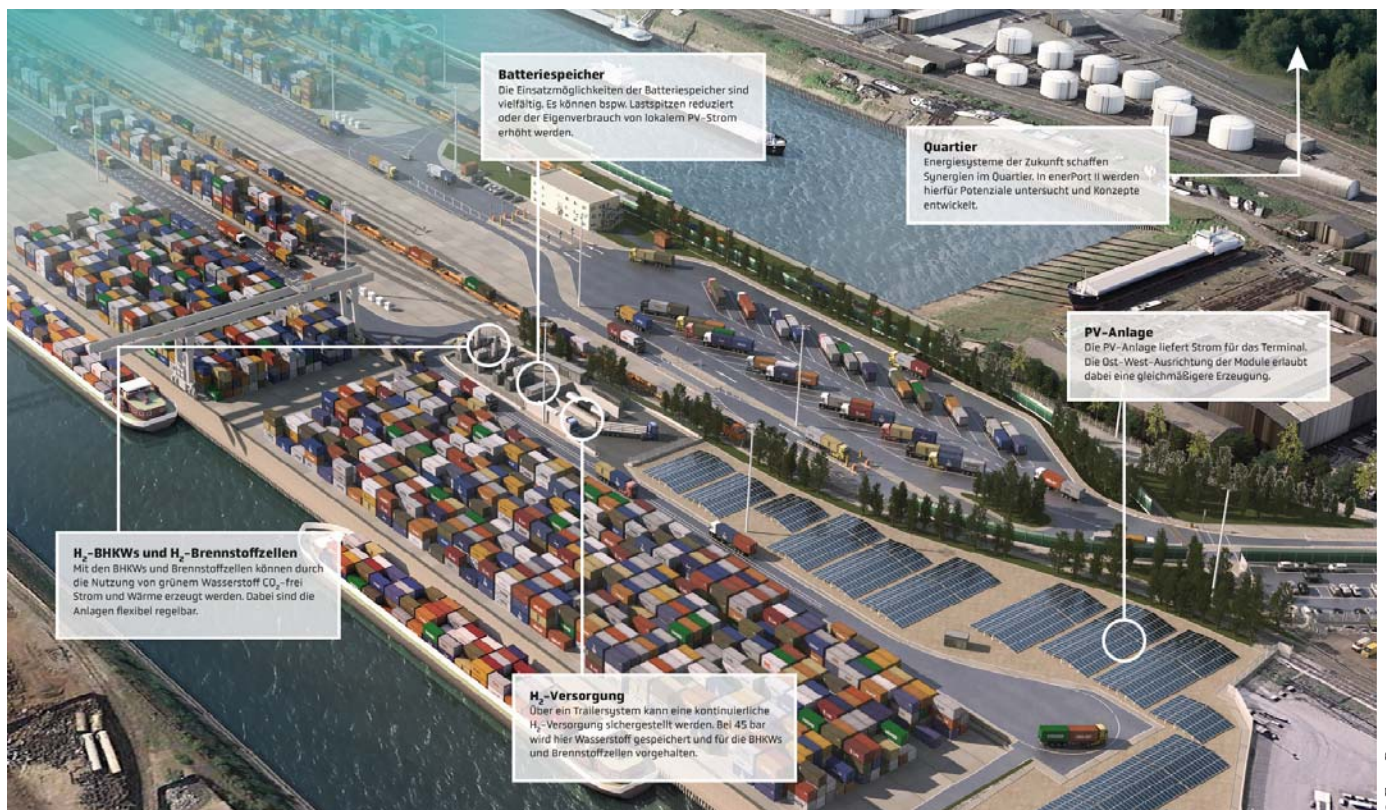
Das DGT wird das erste klimaneutral und mit einer autarken Energieversorgung betriebene Containerterminal in Europa
